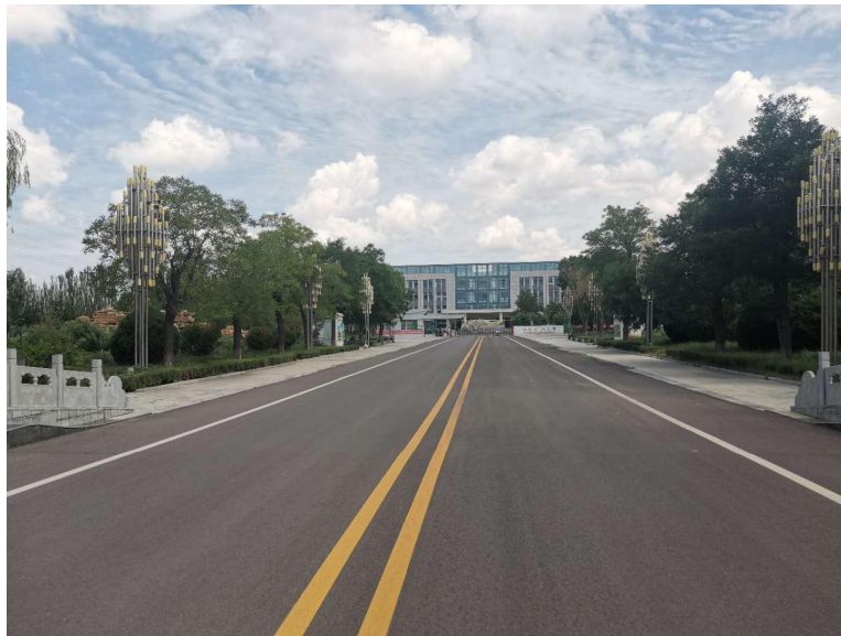
照片 3-4 矿区道路
