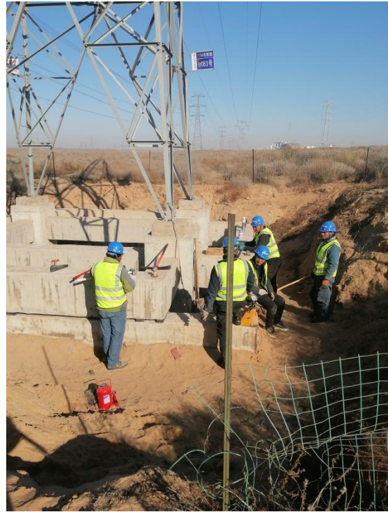
照片4-2 高压线塔加固
