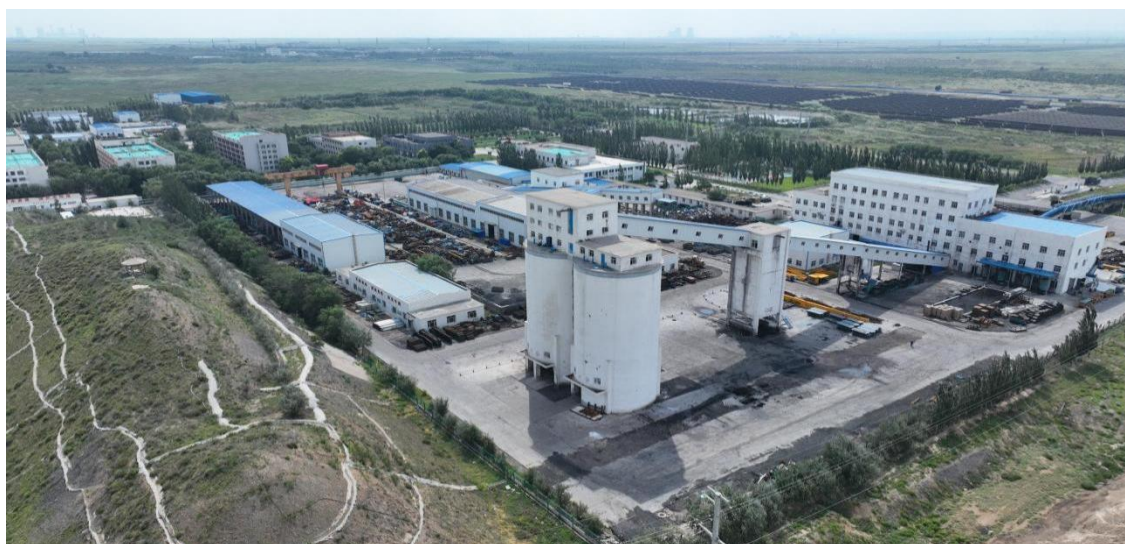
照片 3-2 西北方向鸟瞰工业广场
