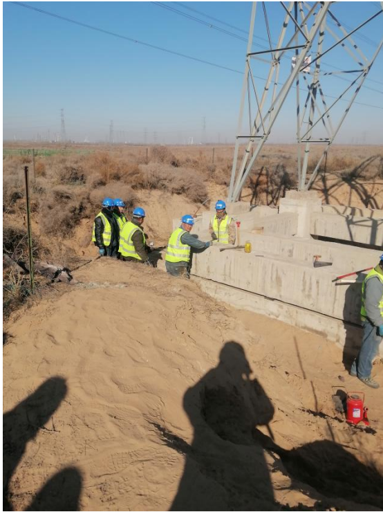
照片4-2 高压线塔加固
