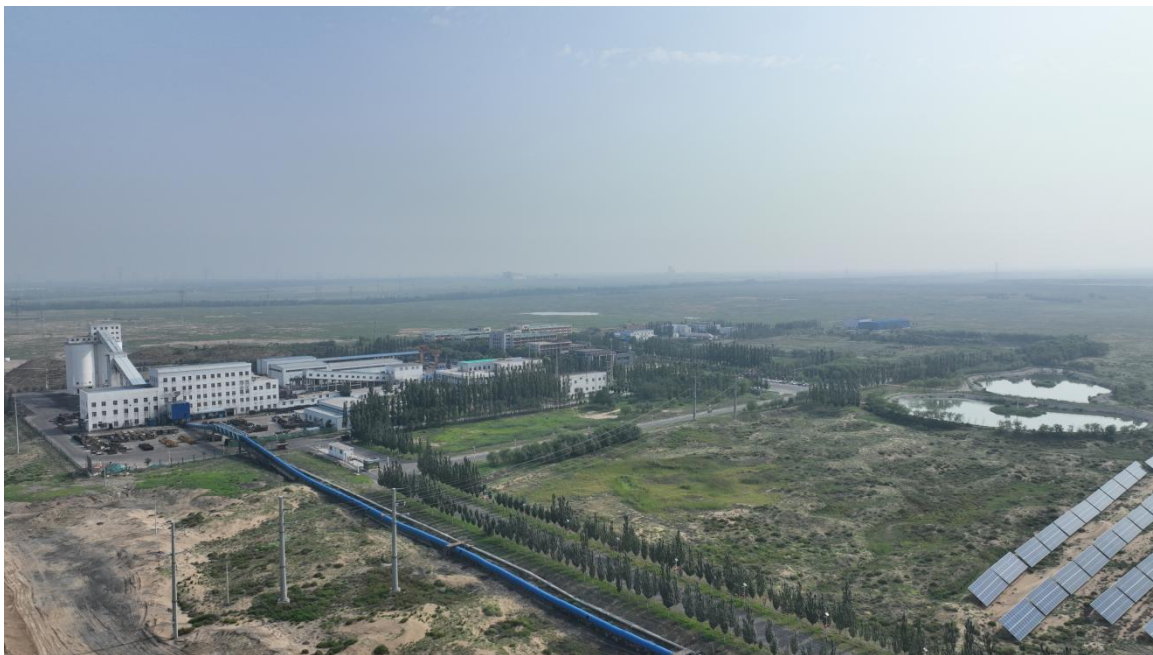
照片 3-5 西南方向鸟瞰进场道路
