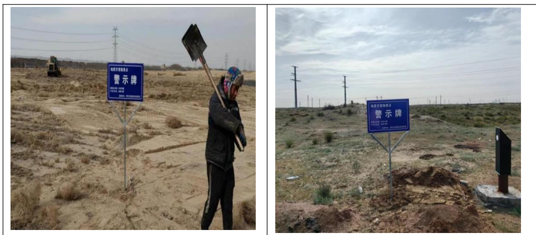
图5-3 警示牌、监测桩
