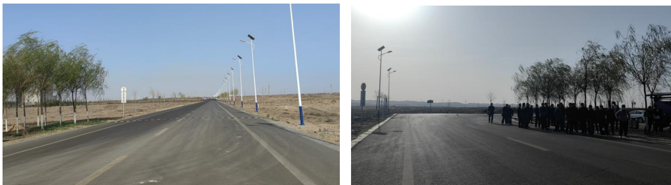
照片3-4 矿区道路
