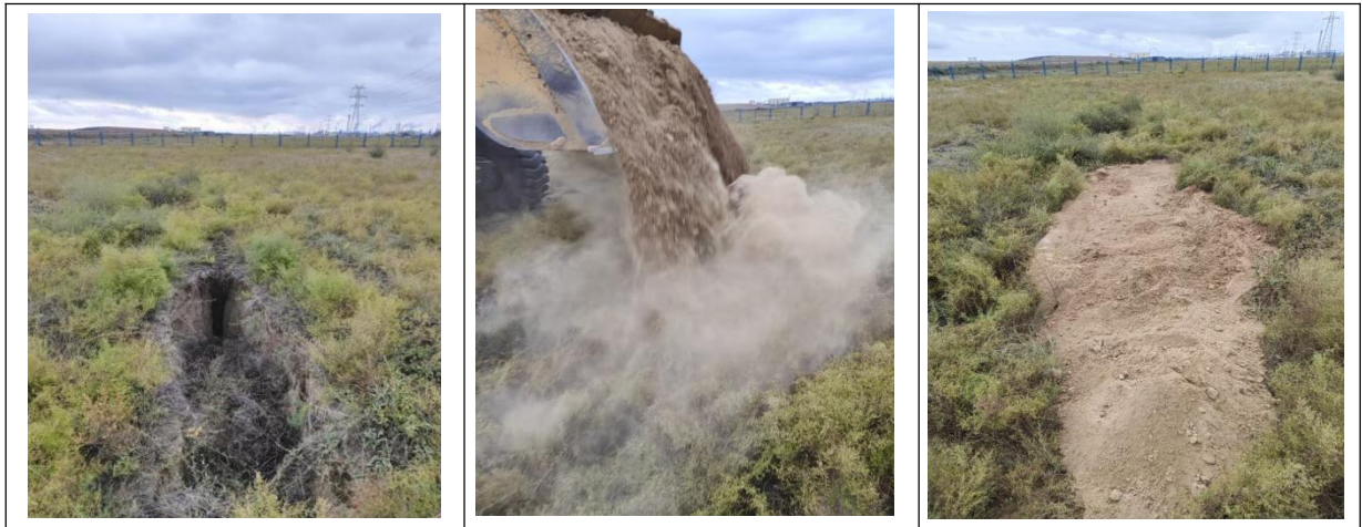
图5-2 回填区覆土，植被恢复、道路修整
