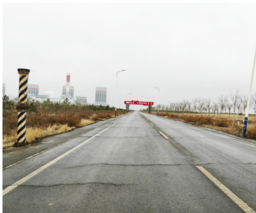
照片 3-4 矿区道路
