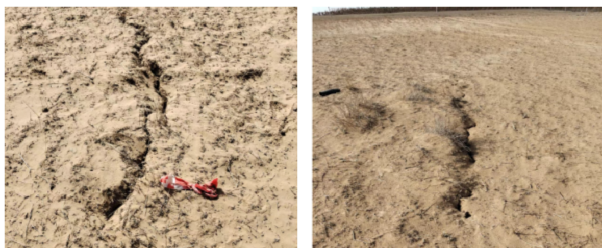
照片 3-1 8、15 煤层采空区对应地表照片
