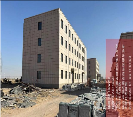
生活区建设情况
