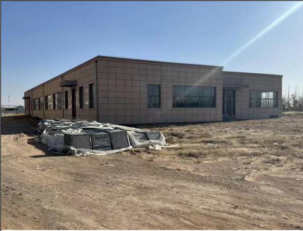
生活区建设情况
