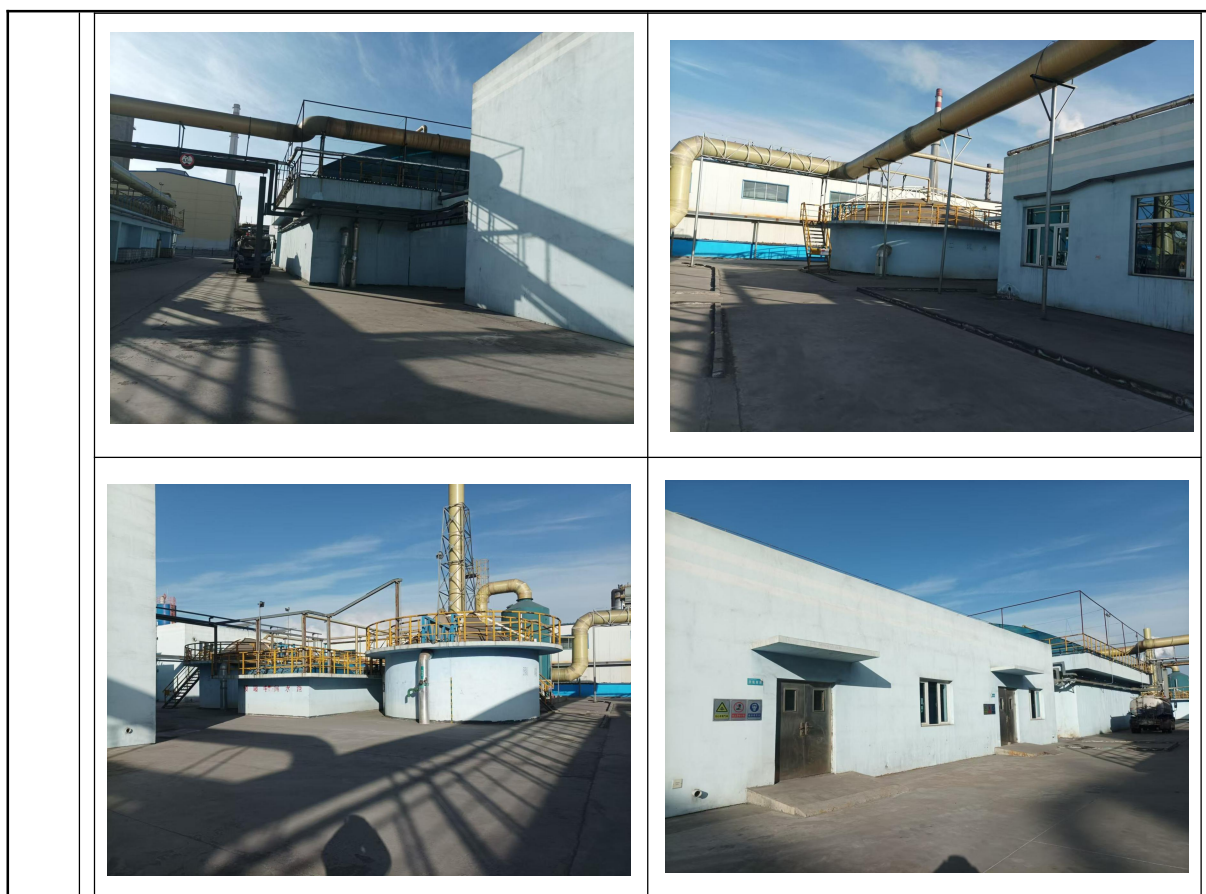
图2-1 厂区污水处理站现有建设情况图
