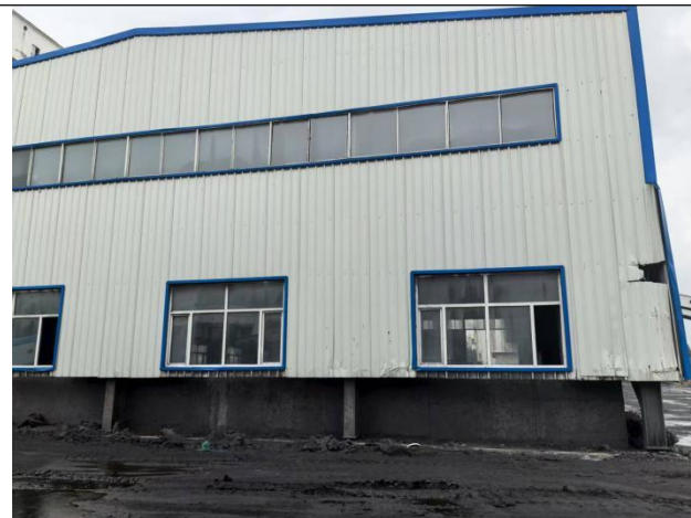
项目南侧中煤棚
