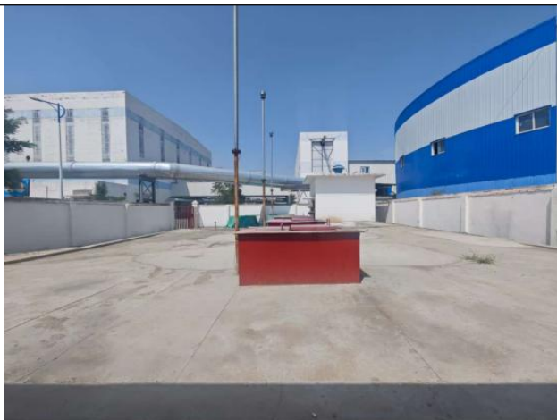
项目西侧（药剂罐）
